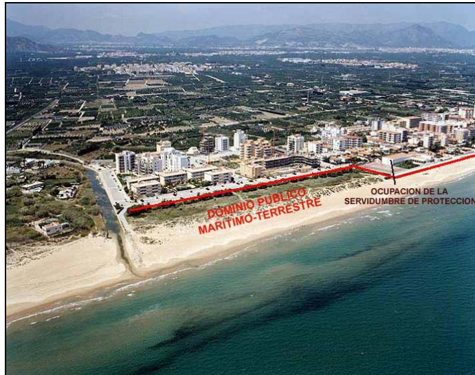
Figura 3. Ocupación de la zona de servidumbre de protección por edificaciones.
