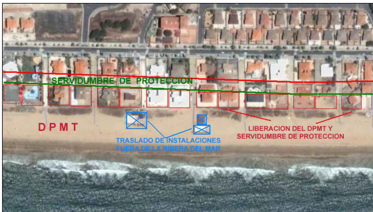
Figura 9. Playa con ocupación del DPMT y zona de servidumbre de protección por edificaciones e instalaciones.
