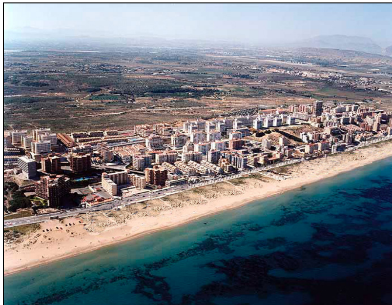
Figura 6. Simulación de la playa mostrada en la figura anterior, tras el levantamiento de las edificaciones situadas sobre la playa.
