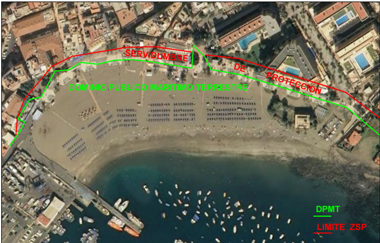
Figura 13. Ejemplo de ocupación por edificaciones de carácter privado de las zonas de DPMT y servidumbre de protección
