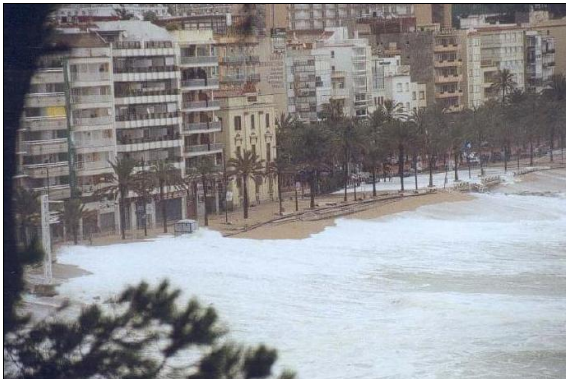
Figura 14. Rebase de un paseo marítimo durante un temporal donde las edificaciones son alcanzadas por el oleaje.
